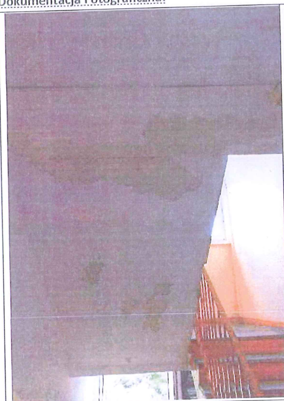
Zdjęcie nr 1. Klatka schodowa od ul. Starzyńskiego
